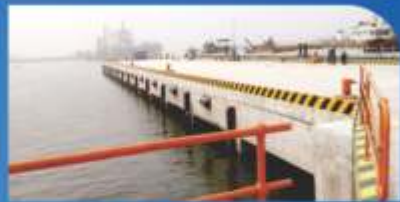
NSL 272m Jetty
